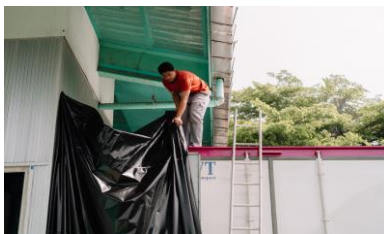
ภาพ 5.4 การทำอุโมงค์ผ้าใบป้องกันแมลงก่อนการขนถ่ายกล่องผลไม้เข้าโรงงานฉายรังสี
